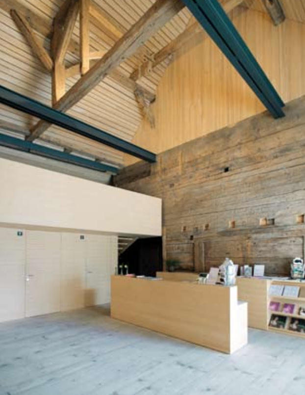
<21_Der Heustall, Stahlträger verstärken die Holzbalken.
