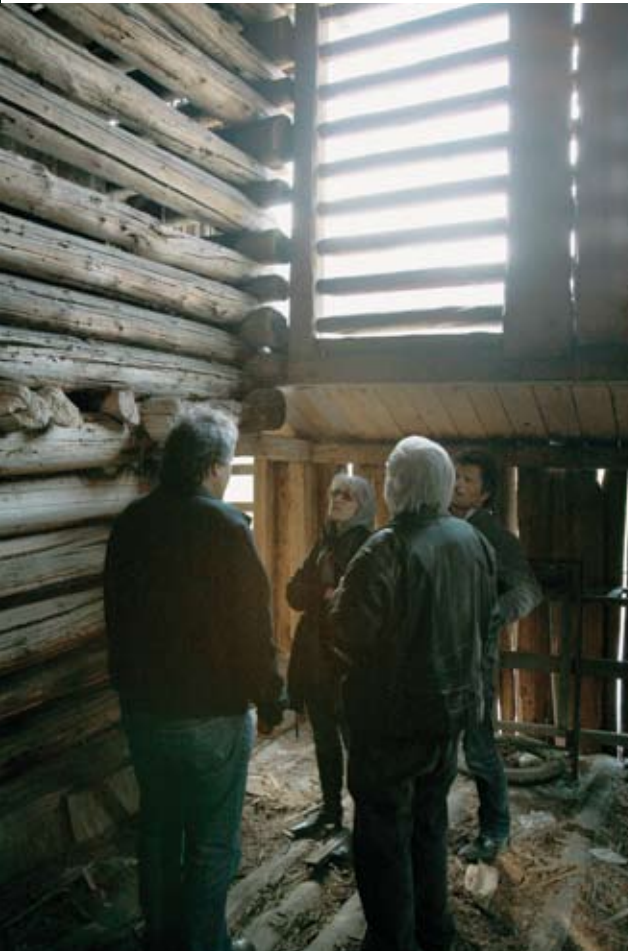
√ Historische Stallerweiterung, vor rund hundert Jahren wurde der Anbau rechts an den Rundstrick angefügt.
