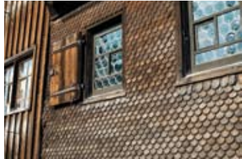
^21_Butzenfenster und Schindelbeschlag, die typischen Attribute.
