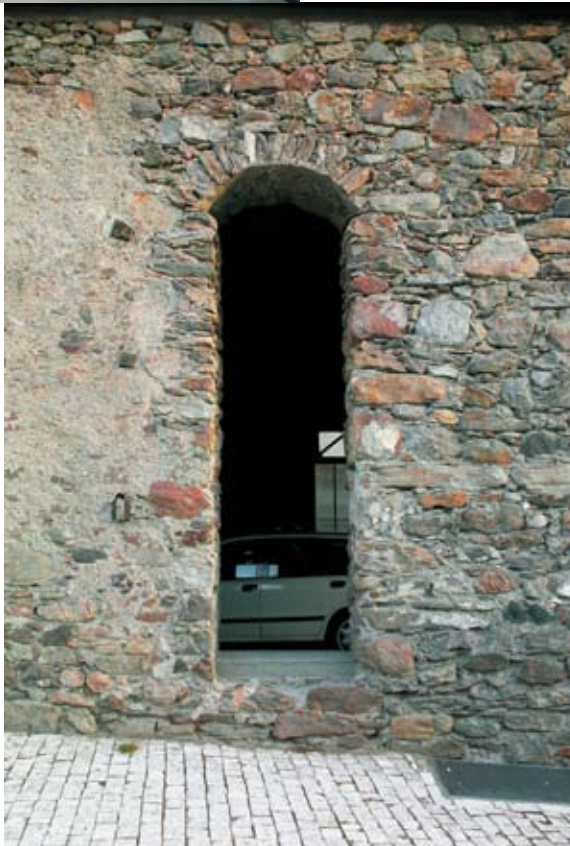
^17_Die Umnutzung war ohne grossen Umbau möglich.
