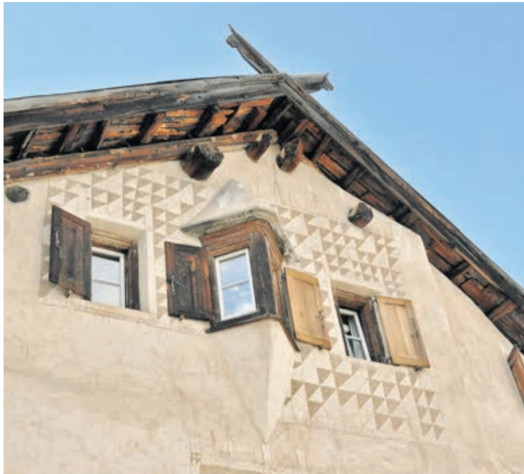
Blick auf die Frontfassade der Chesa Rechsteiner (links) und auf eine Betonwand des Schulhauses Puoz.
